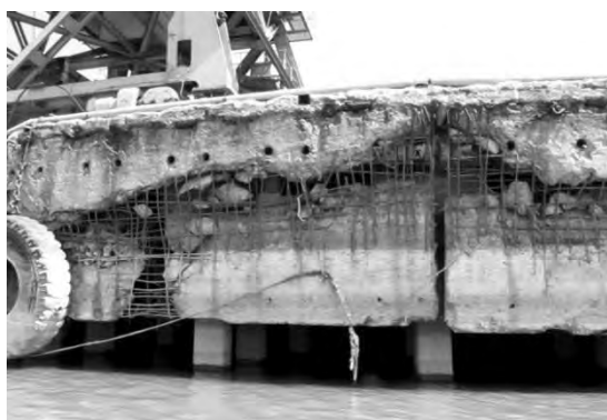
Рис. 2. Состояние бортовой балки
