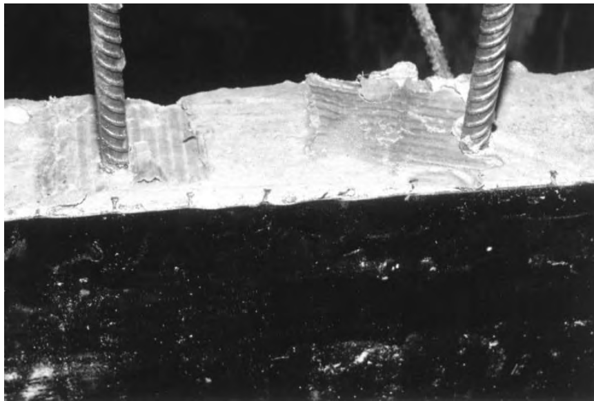
Рис. 2. Обеспечение сцепляемости бетона и полиэтилена
