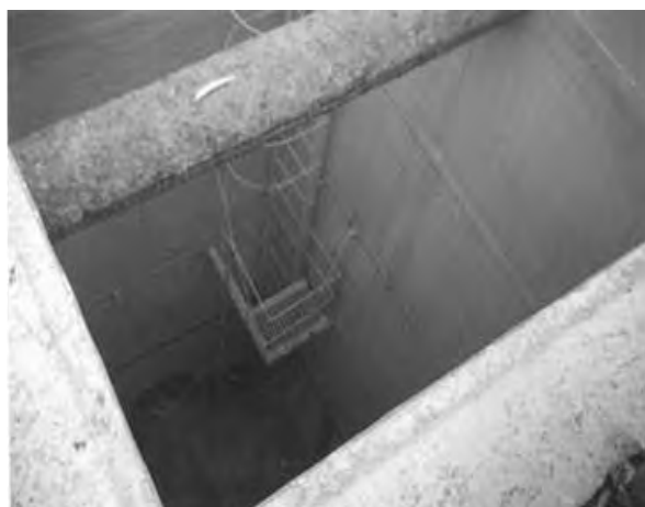
Рис. 5. Шахта после восстановления панелями, облицованными ребристым полиэтиленом
