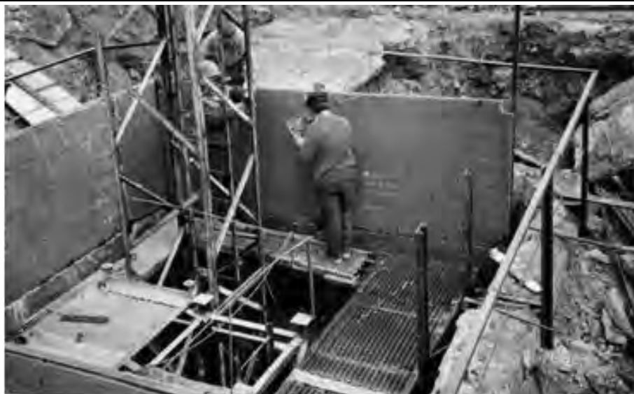
Рис. 6. Общий вид обустроенной строительной площадки смотровой шахты в процессе монтажа шлаколитых панелей
