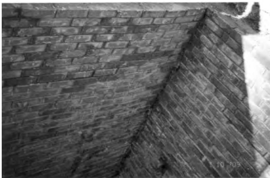
Рис. 7. Вид восстановленной смотровой шахты
