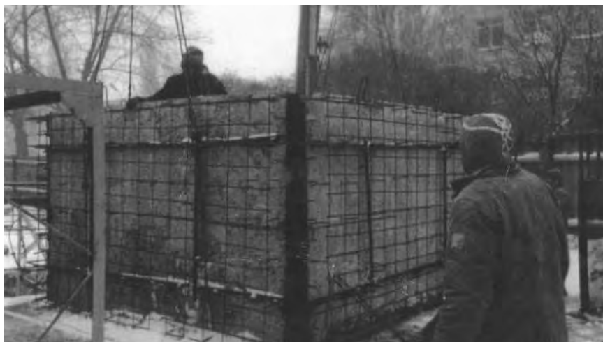
Рис. 3. Подготовленные к монтажу цельносекционные блоки
