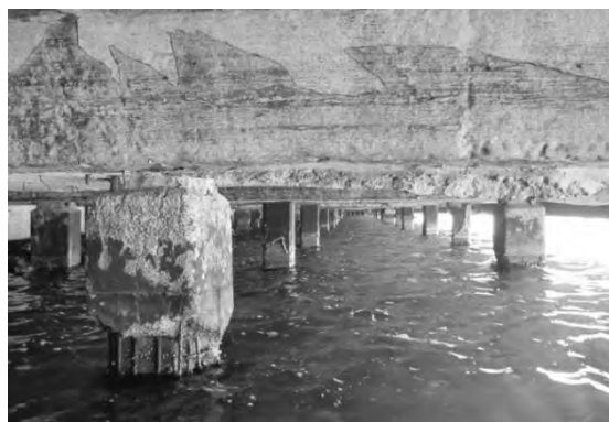
Рис. 3. Повреждения свайного основания
