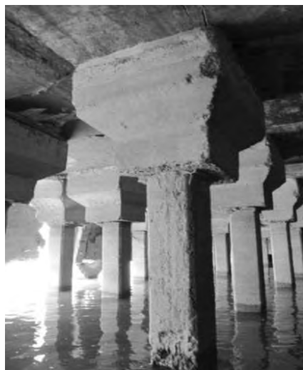
Рис. 1. Состояние свай и наголовника
