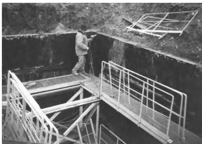
Рис. 4. Сваривание стыков профилированного полиэтилена
