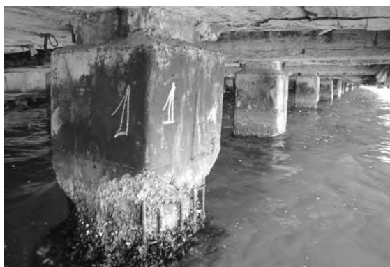
Рис. 3. Повреждения свайного основания
