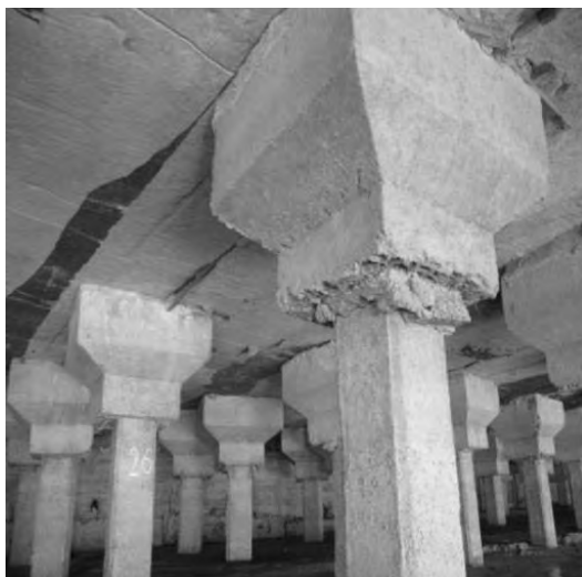
Рис. 1. Состояние свай и наголовника
